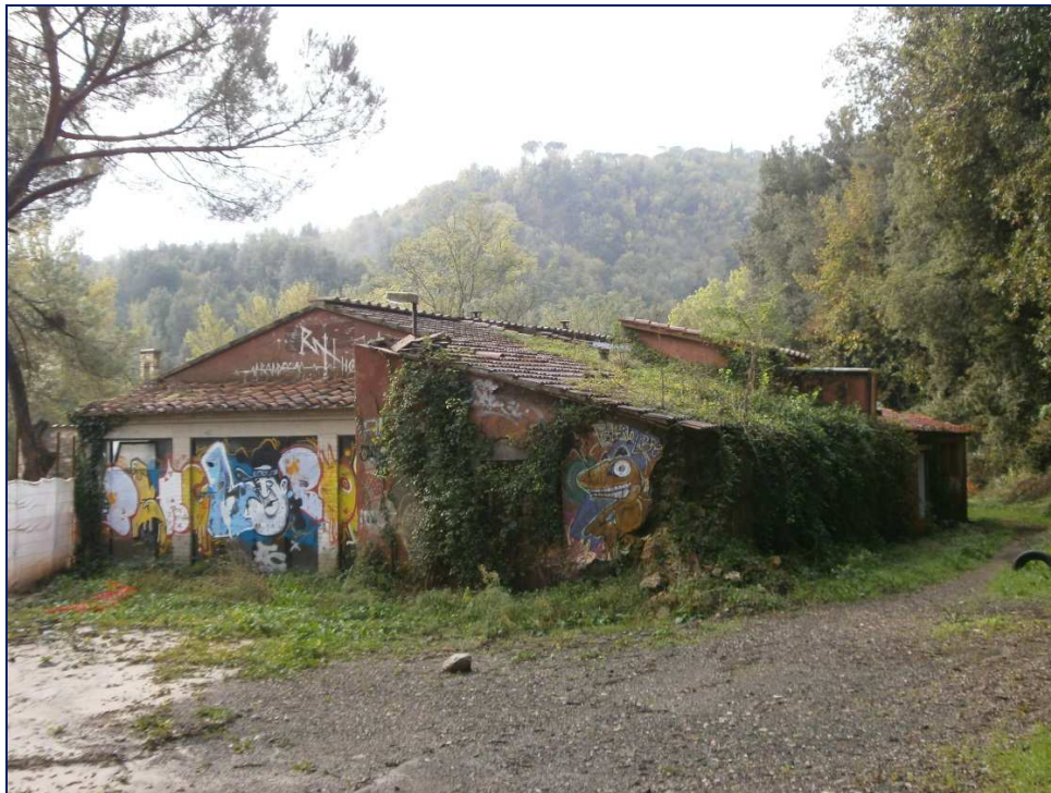
FOTO n. 2. Prospetto principale delle Vecchie Terme. L'edificio versa nel completo degrado e abbandono.
