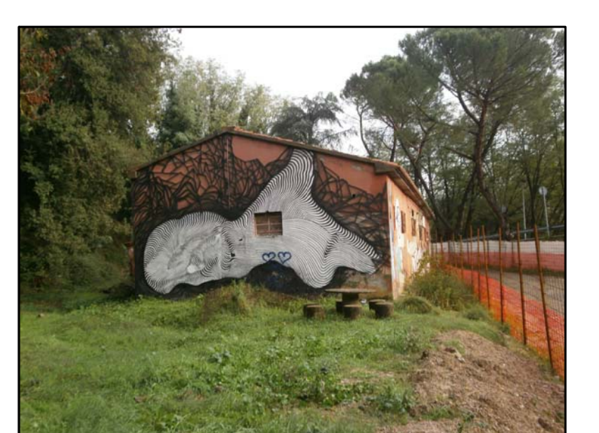
FOTO n. 4. Facciata opposta dell'edificio
